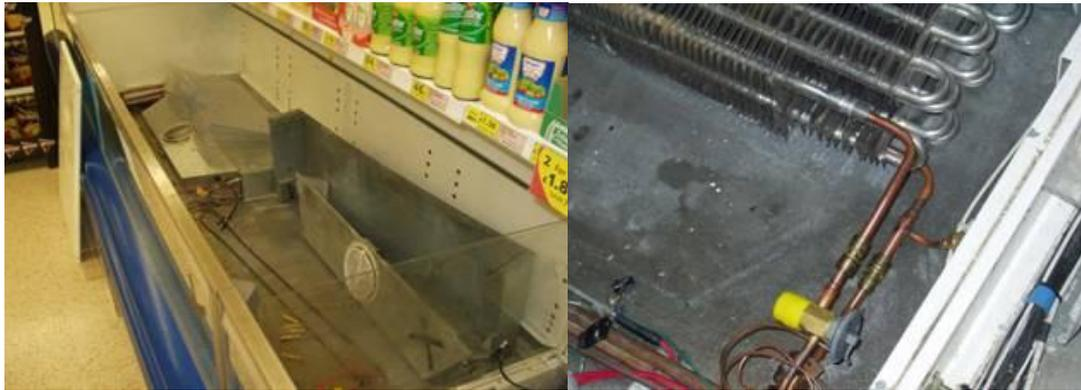
图4 洛克林制冷管焊接配件在实际应用中的照片
